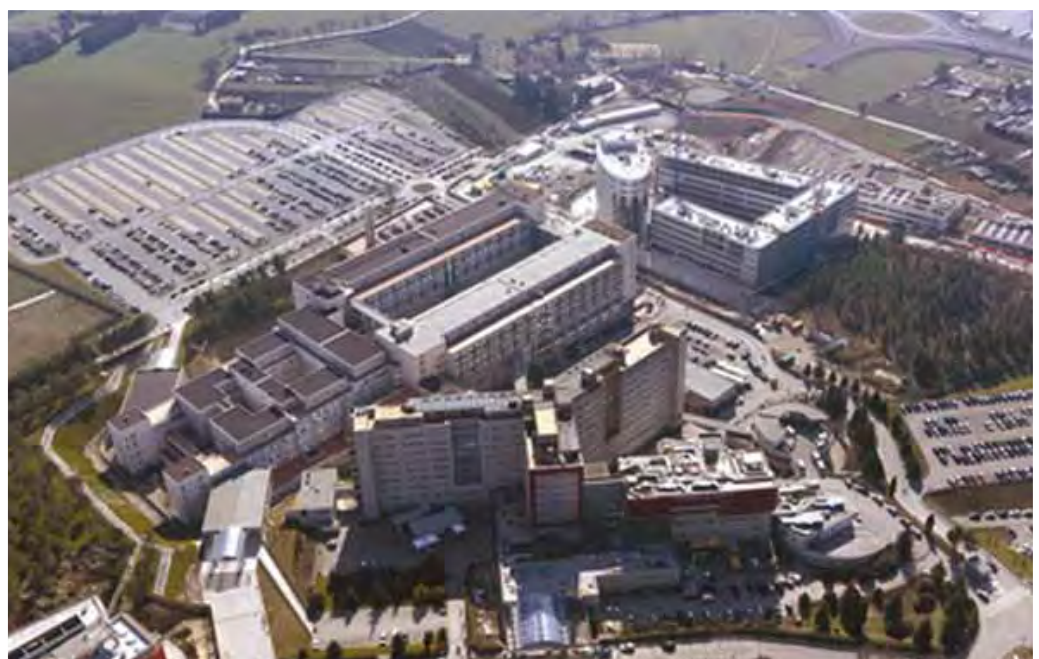
Santa Maria della Misericordia aerial view
